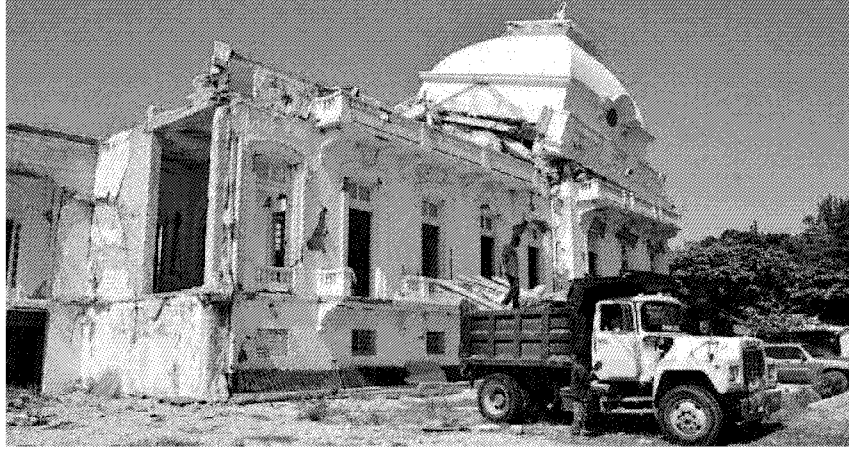
Il palazzo presidenziale a Port-au-Prince devastato dal terremoto del 2010
